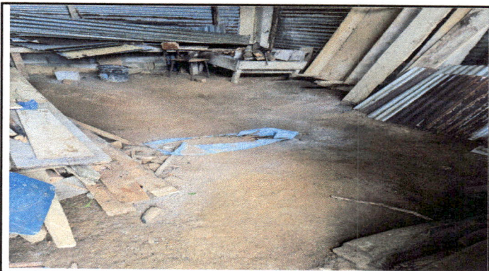
Foto 4: Colocacion de piso de torta de cemento.
