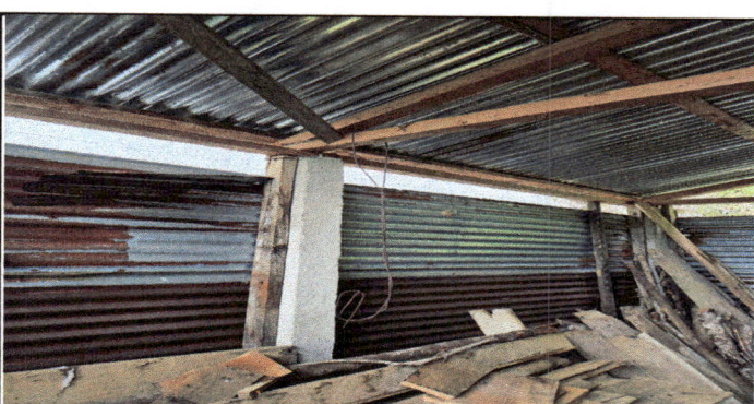
Foto 6: Sustitucion de ventanas de lamiana a metal.
