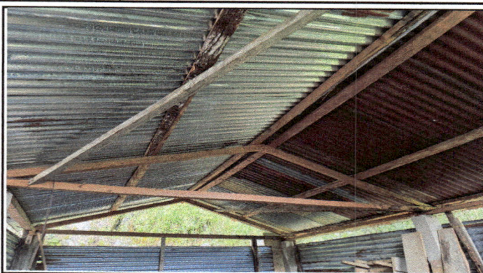
Foto 2: Sustitucion de estructura de techo.
